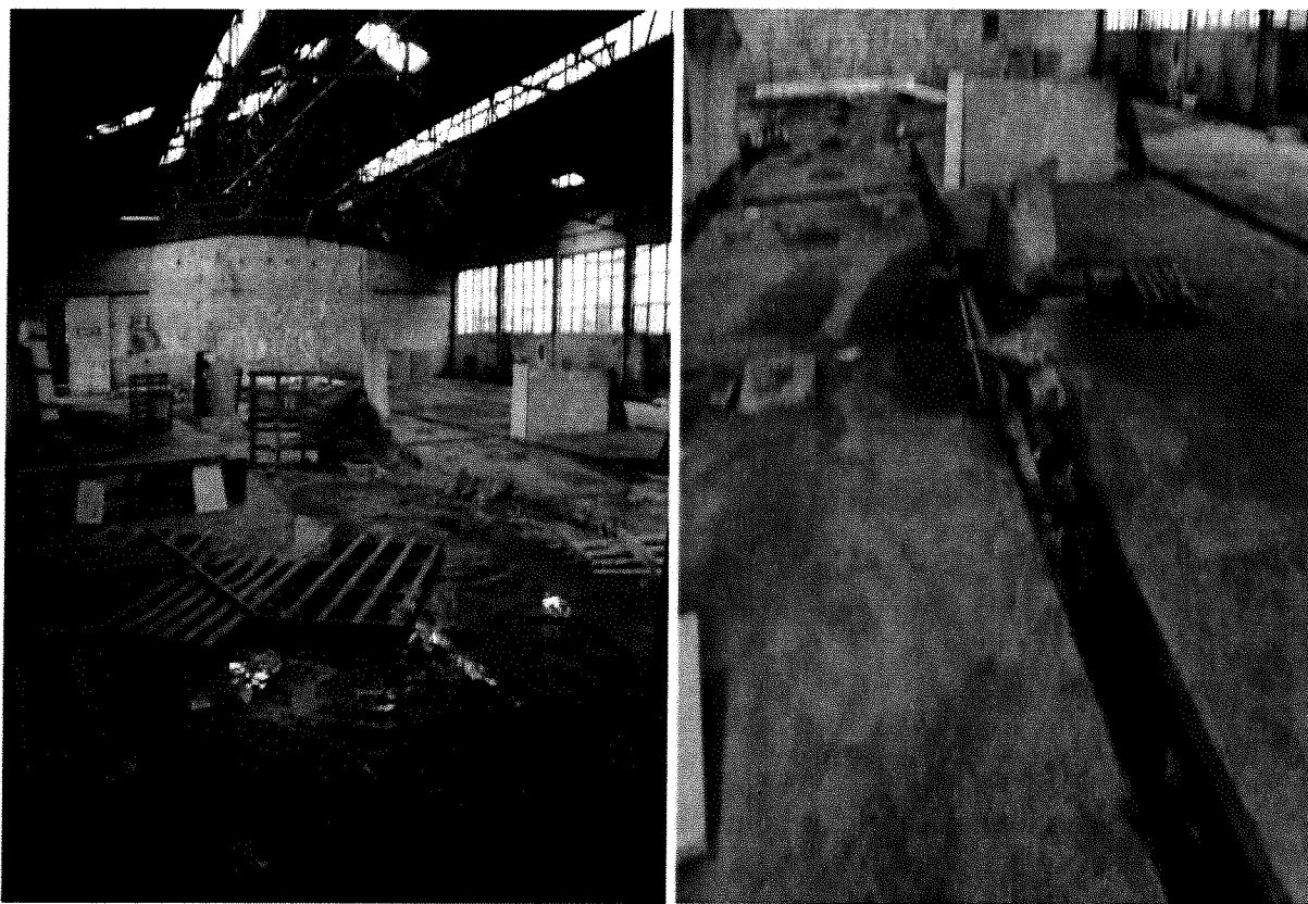
Pièce principale avant intervention
