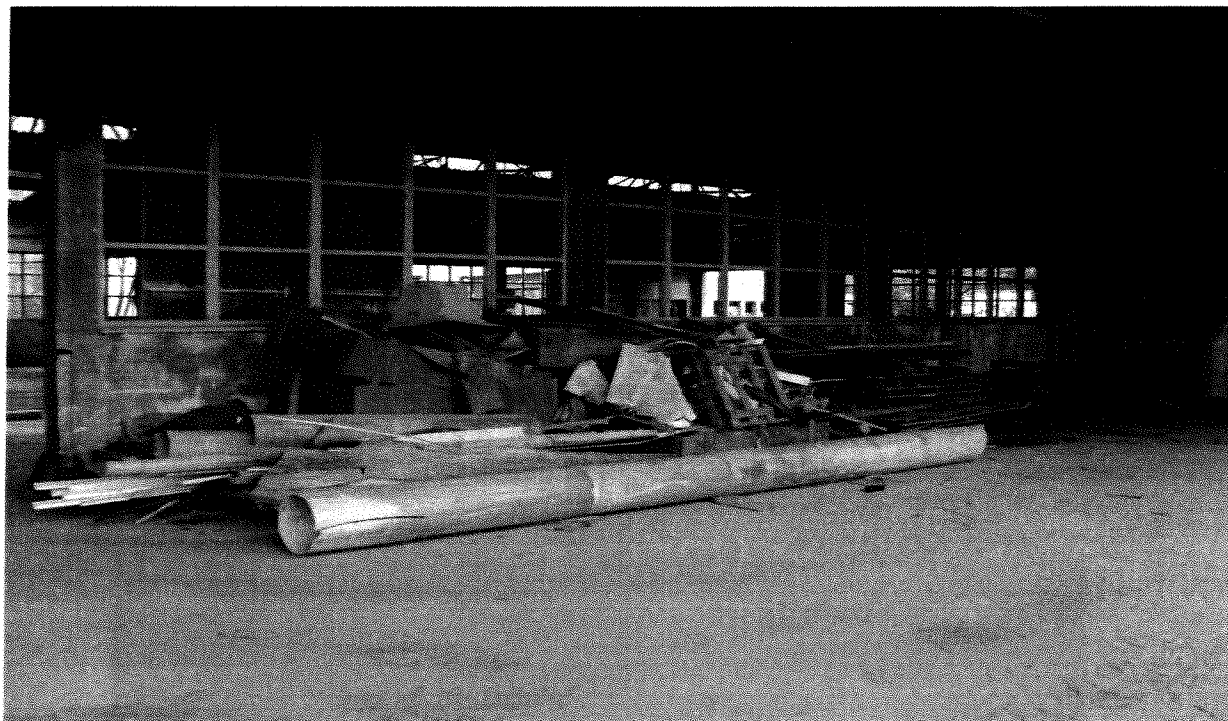
Stockage sur site des déchets banals par famille : BOIS-FERRAILLE-DIB
